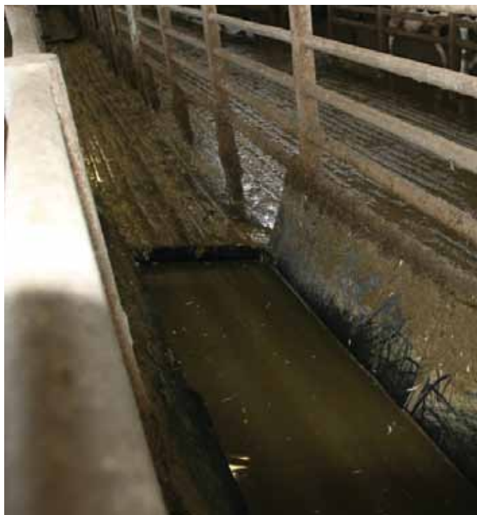
Fig.1 - Novas directrizes para a construção de pedilúvio recomendam 3-3.7m de comprimento, 26cm de altura (para uma altura do banho min. 9cm), 60cm de largura com a possibilidade de acesso lateral. As “paredes” laterais devem consistir de painéis em “V” para garantir a imersão das patas na solução
