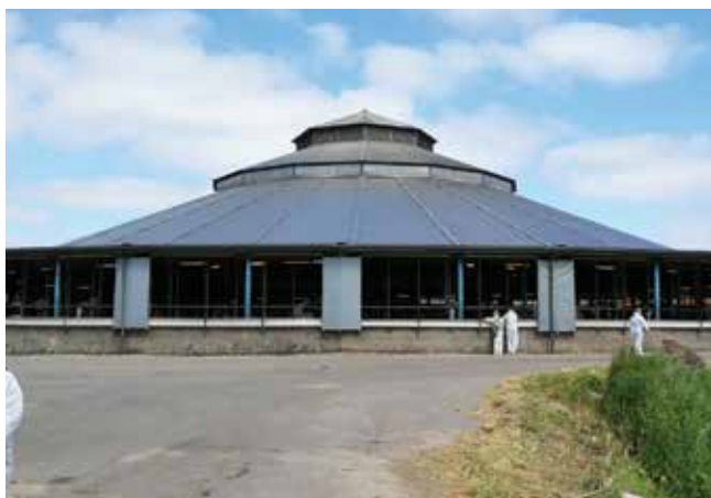
| Pavilhão circular de vacas em produção com ordenha rotativa no centro e alimentação automatizada
