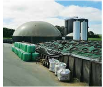
| Planta de biogás
