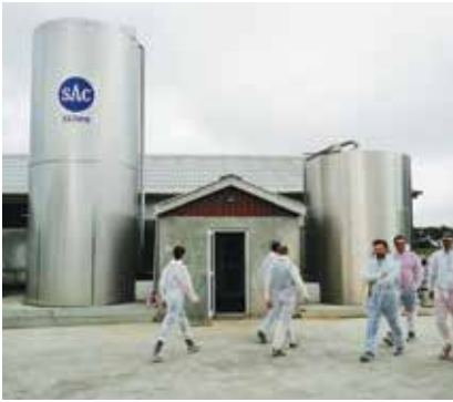
| Sala de ordenha com 2 tanques verticais para separação de leite de vacas de parques diferentes
