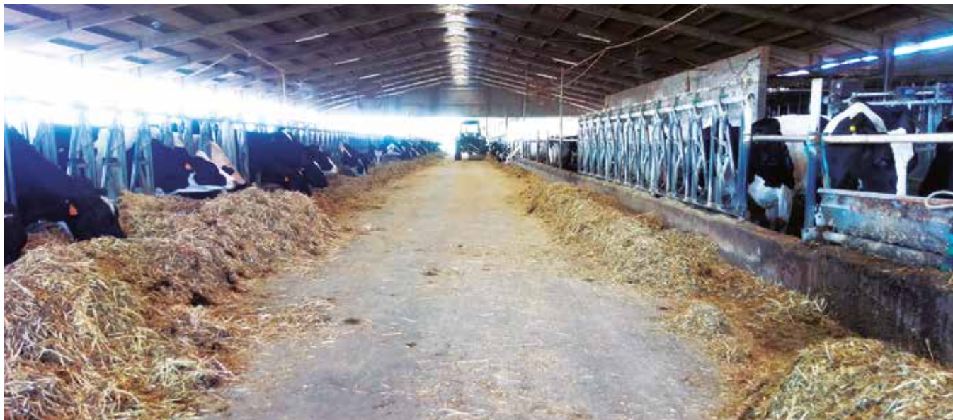
| Estábulo da Nederleite com 30mX80mX9m (largura, comprimento, altura ao centro)
