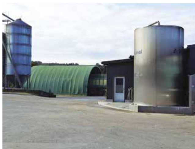
Tanque de Refrigeração / Silo DeLaval
